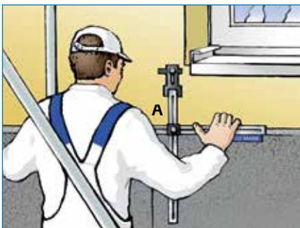
Plaatsen van de horizontale aanslag (A) van de sjabloon op het aanwezige isolatiemateriaal met inachtneming van de voorgeschreven plaattruimte.
