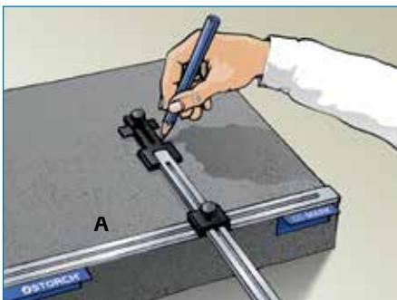
Šablonu s vodorovným dorazem (A) přiložte přesně k okraji desky na izolační desce a poté vyznačte značky řezu.
