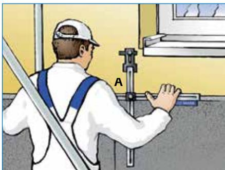
Pose de la butée horizontale (S) des calibres sur la rangée isolante précédente en respectant le décalage de panneau prescrit.
