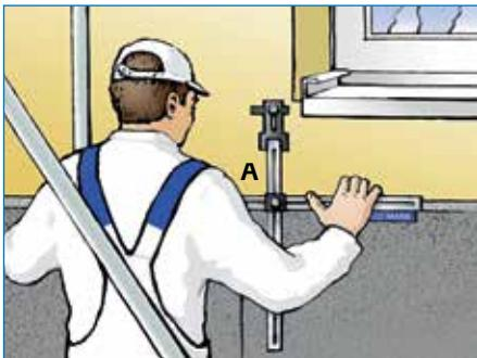
Posizionamento dell'arresto orizzontale (A) del modello sulla fila precedente di pannello isolanti, rispettando lo spostamento prescritto dei panelli.
