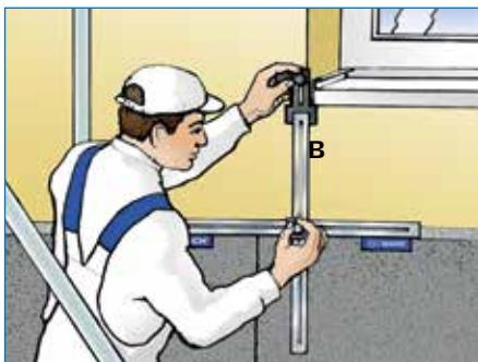
Décalage de la butée verticale (B) vers la droite jusqu'à la banquette de fenêtre et vers le haut pour la détermination de l'arête inférieure de la banquette de fenêtre.
