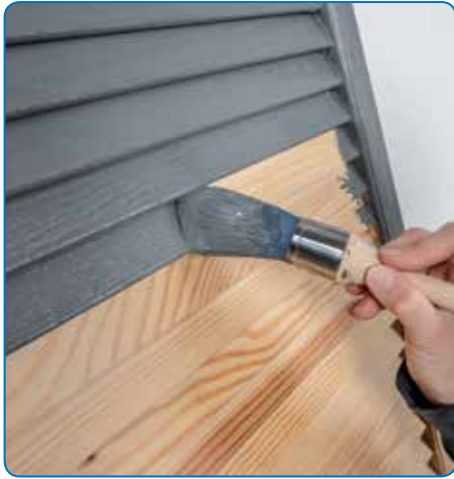
Lackierung eines Fensterladens an schwer zugänglichen Flächen
